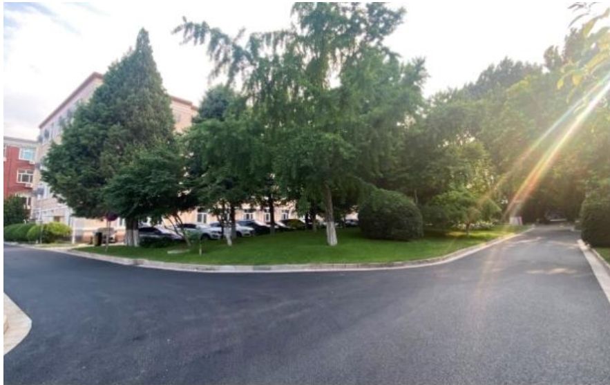
图注 39：路面铺设
