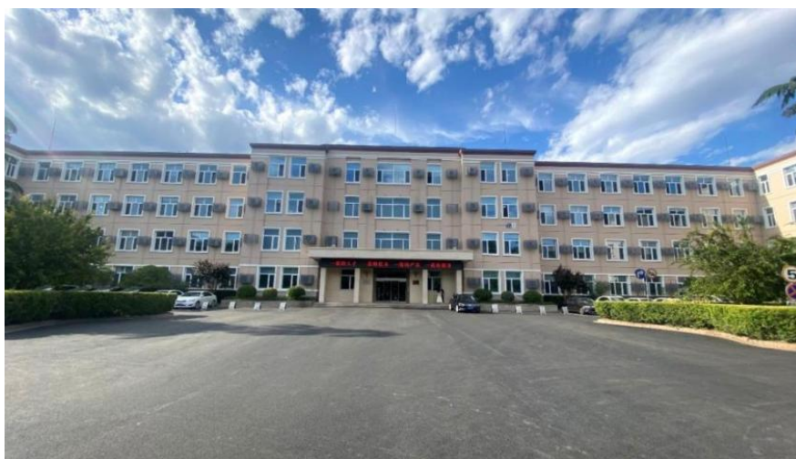
图注 40：办公楼翻新
